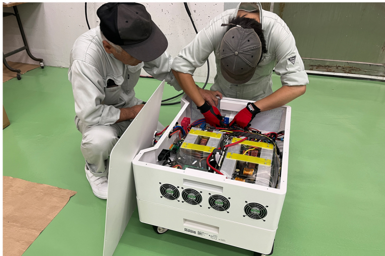
バッテリー他接続と内部配線の検査
