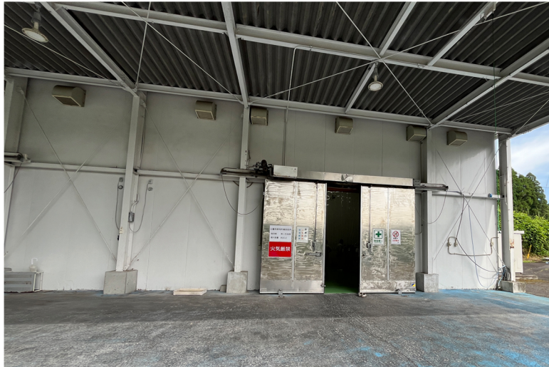
空調管理された検査室、保管室
